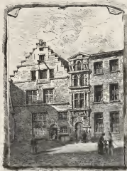
Façade de la maison bâtie en 1549 par Jean Adriaensen, peintre et doyen de la corporation de St-Luc.
